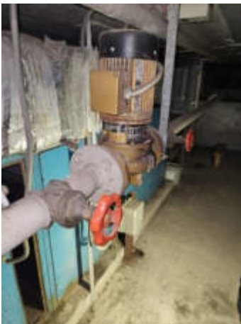
Abb. 4: Beispielhaft Ansicht einer Stopfbuchsenpackung
