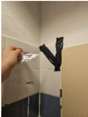
Abb. 14: Beispielhafte Ansicht einer Fliese mit asbesthaltigem Fliesenkleber
