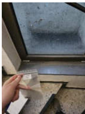
Abb. 10: asbesthaltige schwarze Fensterbank aus Faserzement
