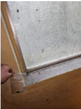
Abb. 9: asbesthaltige graue Fensterbank aus Faserzement
