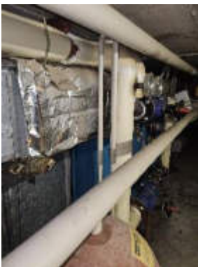
Abb. 19: KMF-Dämmung der Schwimmbadtechnik
