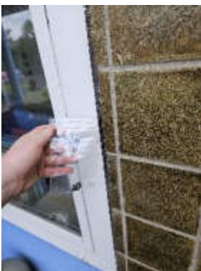
Abb. 16: schwarze Fugenmasse an Anschlussfuge
