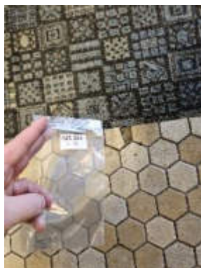
Abb. 12: asbesthaltiger Fliesenkleber unterhalb von Fliesen
