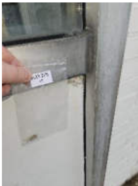
Abb. 6: asbesthaltiges Fassadenelement
