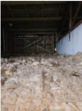
Abb. 20: KMF-Dämmung im Bereich der Aufbaus
