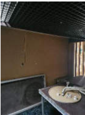
Abb. 24: KMF-Dämmung hinter Holzverkleidung
