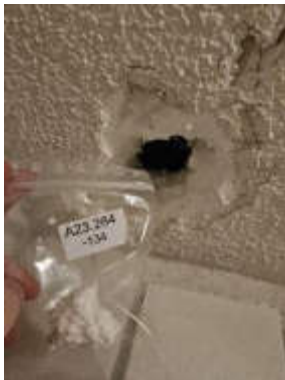
Abb. 13: schwarzer Fliesenkleber unterhalb der Polystyrol-Dämmung
