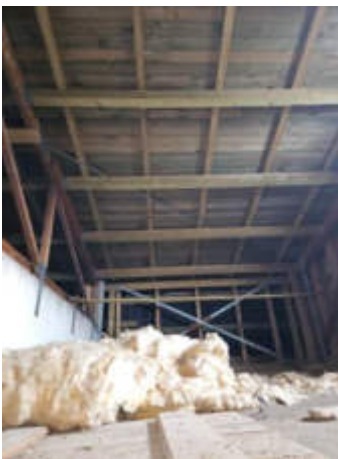
Abb. 41: Ansicht des Aufbaus im Dachbereich aus Holz
